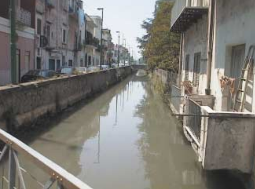
Fig. 10 Canale Bottaro - Scafati - via Zara
